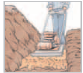
Fig. 2 - Base de nivelación
